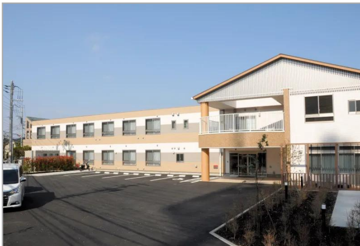
【ミモザ藤沢躑躅苑】施設外観
