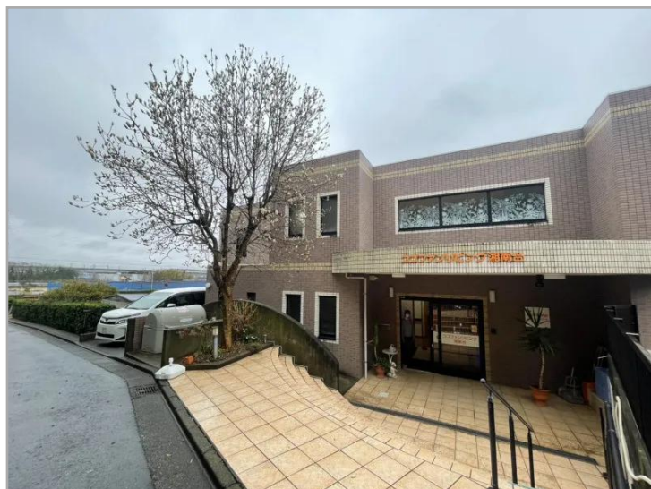
【ココファンリビング湘南台（女性専用）】外観
