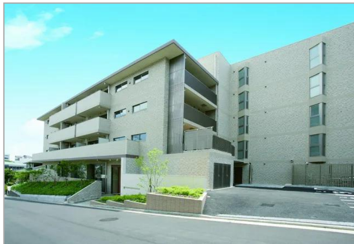
【クレールレジデンス桜台】外観
