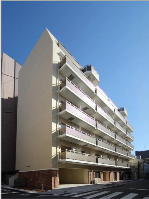
【リリィパワーズレジデンス貝塚】リリィパワーズレジデンス貝塚 建物外観
