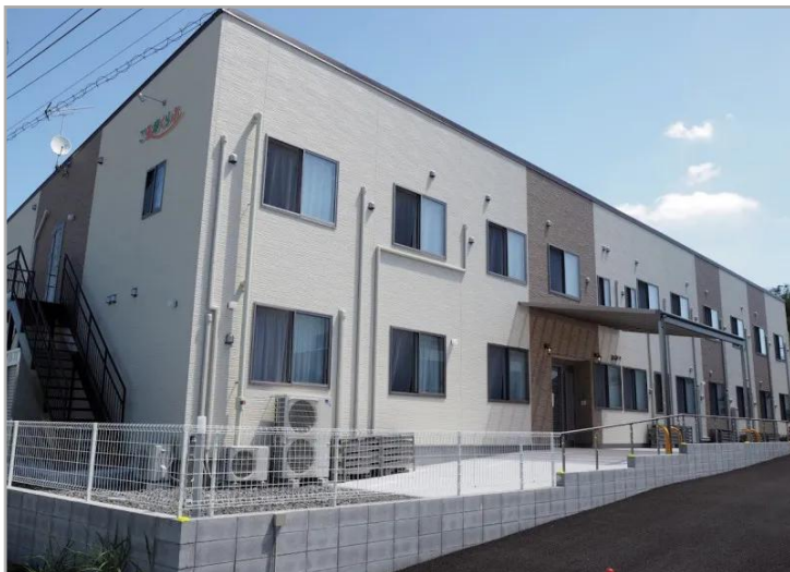
「ご長寿くらぶ野田清水公園南館」外 観：居室は23室、居室面積は18.83㎡～26.91㎡です。
