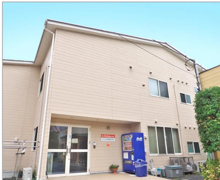
ベテラン館はらいちば：外観
