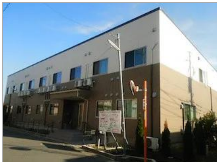
ご長寿くらぶ川口新井宿 外観
