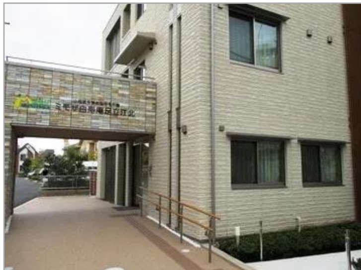
【ミモザ白寿庵足立江北】外観
