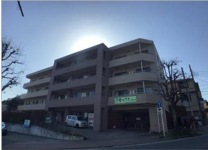
【サービス付き高齢者向き住宅万葉のさと梶ヶ谷】外観
