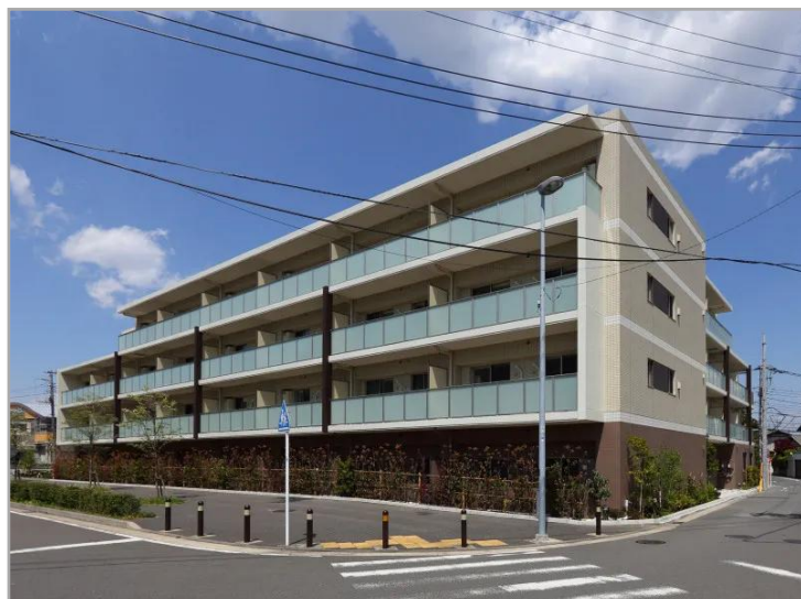
【グランドマスト横浜鴨居】外観。
