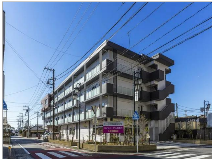
【コンフォータス湘南台】施設外観
