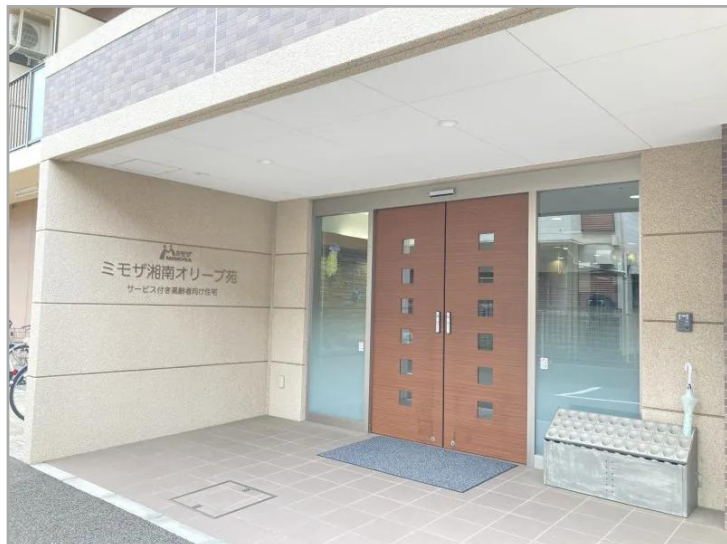
【ミモザ湘南オリーブ苑】エントランス
