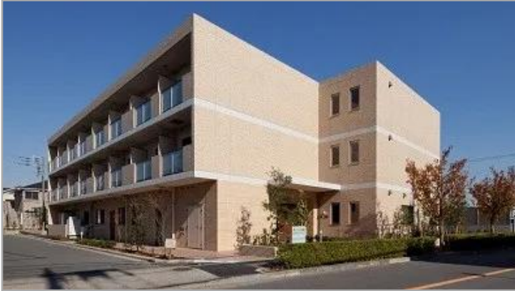
【そんぽの家S北綾瀬】外観
