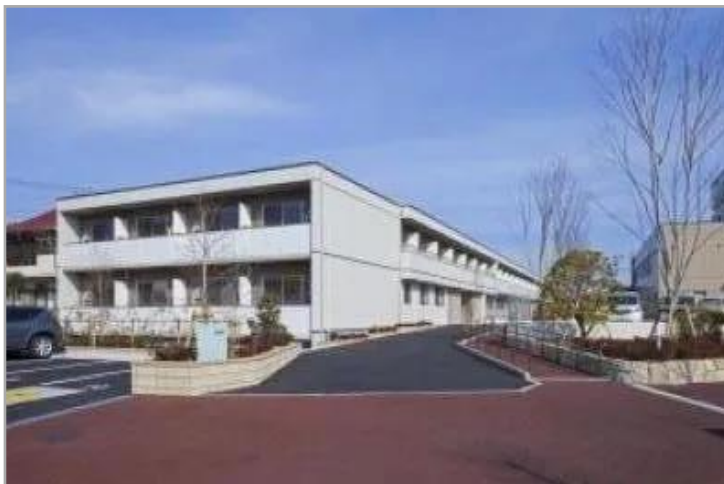
【そんぽの家S武蔵砂川】外観
