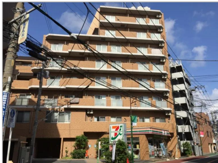
【そんぽの家S西大井】外観
