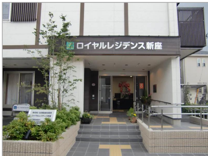
ロイヤルレジデンス新座（外観1）優しい和モダンの雰囲気の造り
