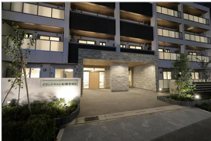
【グランドマスト船橋高根台】施設外観エントランス
