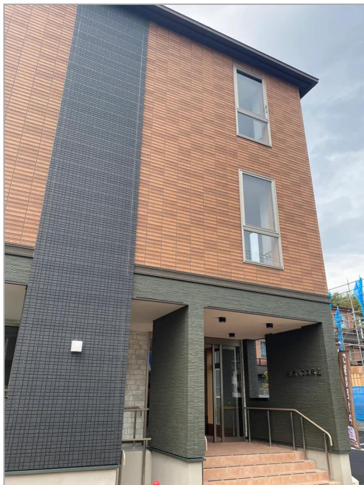
【和気ハウス麻生】外観
