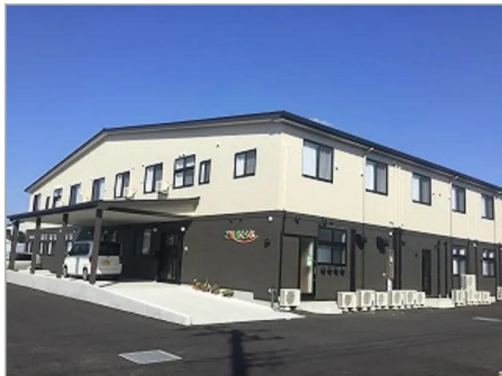
【ご長寿くらぶ鎌ヶ谷の外観】
