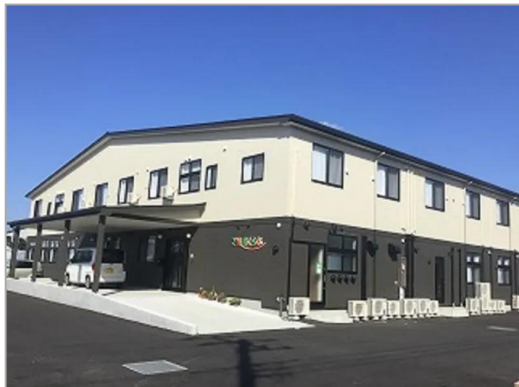
【ご長寿くらぶ鎌ヶ谷の外観】
