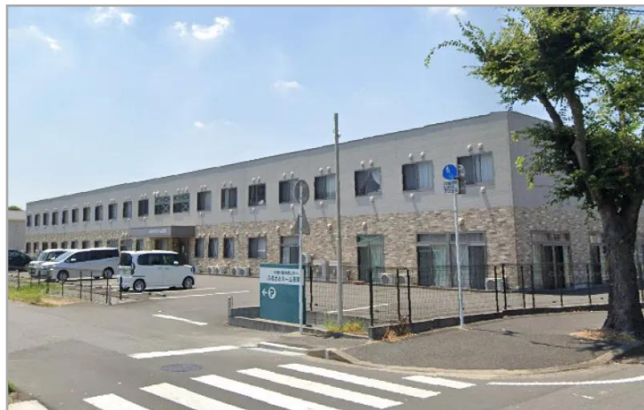
【ふるさとホーム市原の外観】
