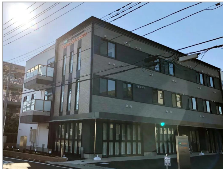
【ココファン船橋三咲の外観】
