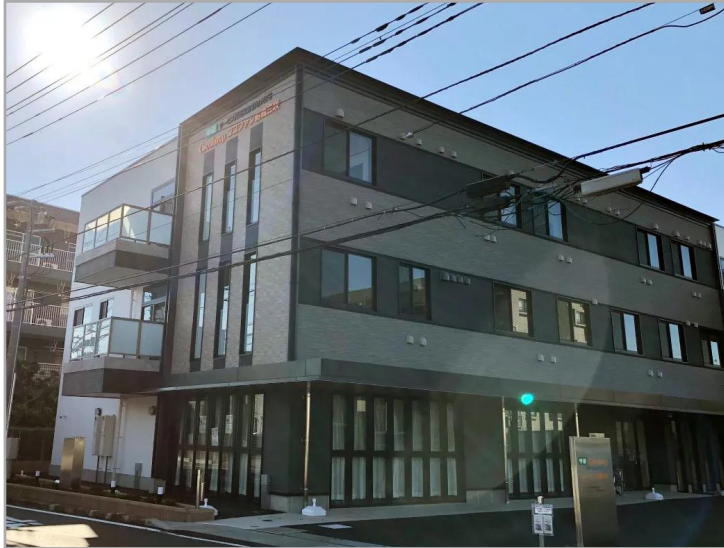
【ココファン船橋三咲の外観】
