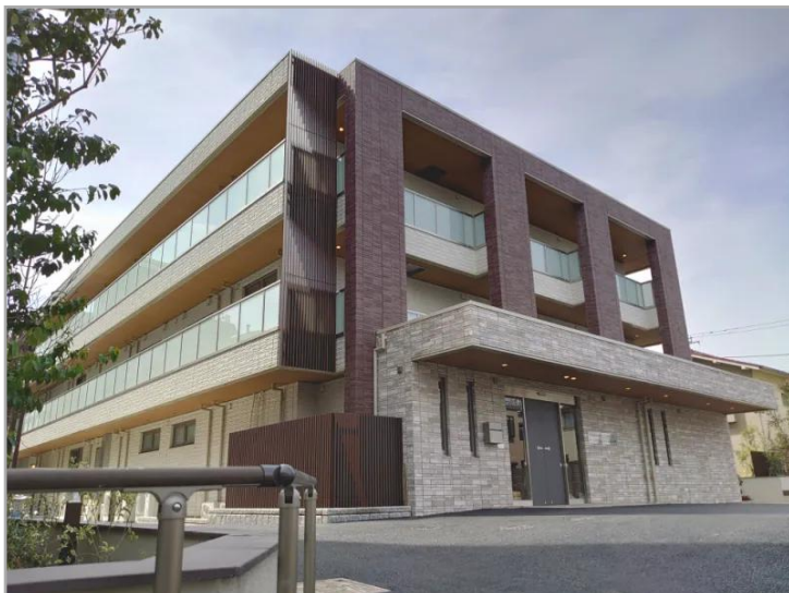
【ホームステーションらいふ高井戸】：外観
