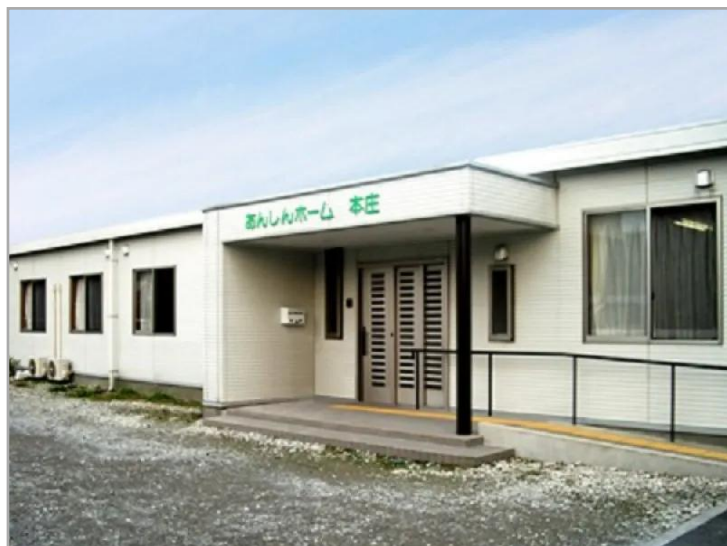
【サービス付き高齢者向け住宅あんしんホーム本庄の外観】
