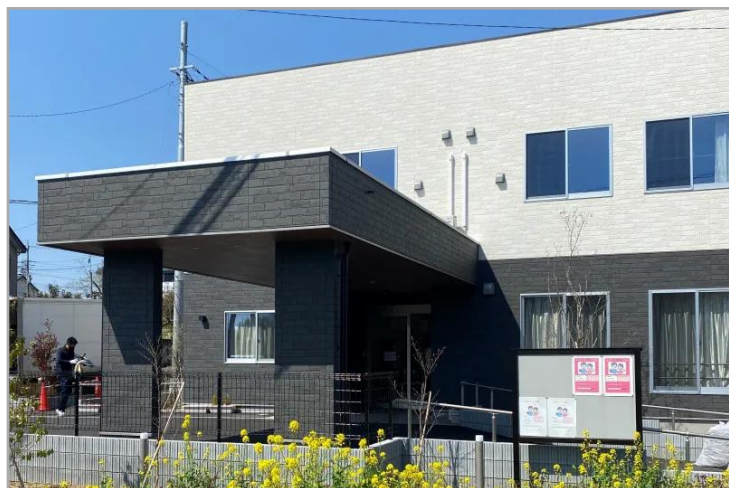
サービス付き高齢者向け住宅「ウールズ運河」外観
