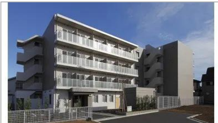
【そんぽの家S久米川】外観
