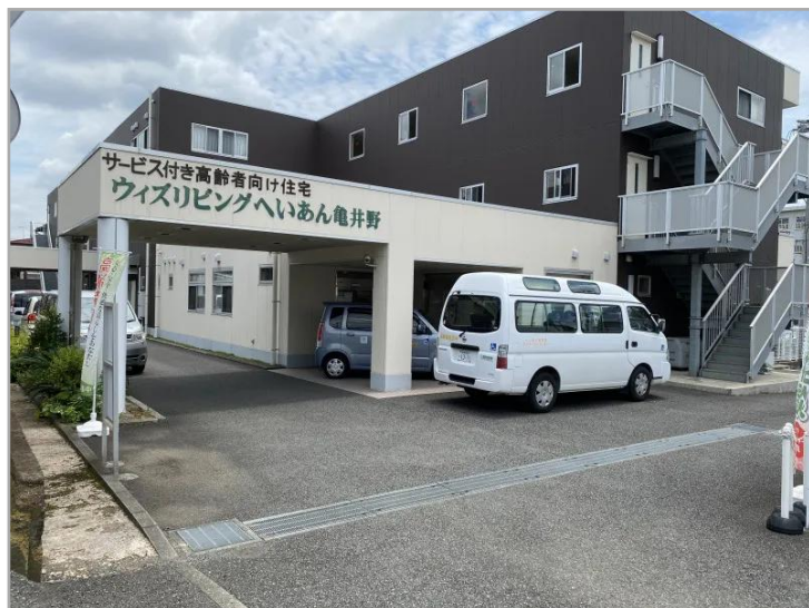
【ウィズリビングへいあん亀井野】 外観 建物は藤沢街道沿いです
