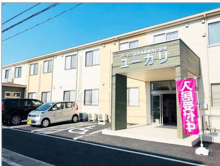
【サービス付き高齢者向け住宅ユーカリの外観】
