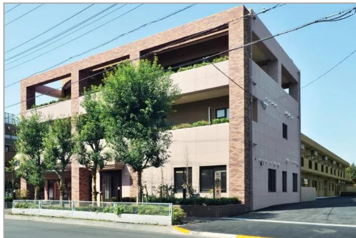
【西東京ケアコミュニティそよ風】施設外観
