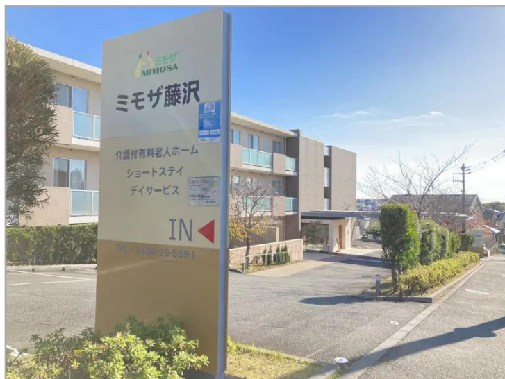
【ミモザ藤沢】施設外観
