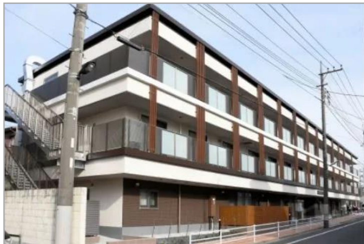
【ミモザ板橋けやき苑】外観
