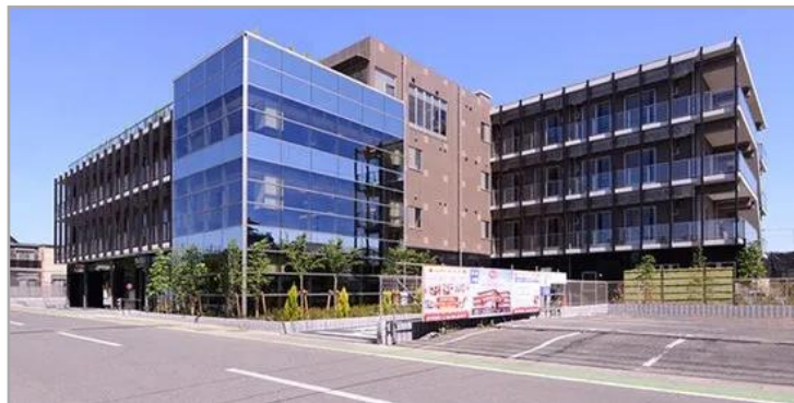
メディカルフローラ岩槻 外観 鉄筋コンクリート4階建て耐火建築物 65室 敷地面積1925.71㎡/延べ床面積3196.9㎡
