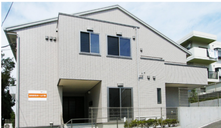
【はなまるホーム十条の外観】
