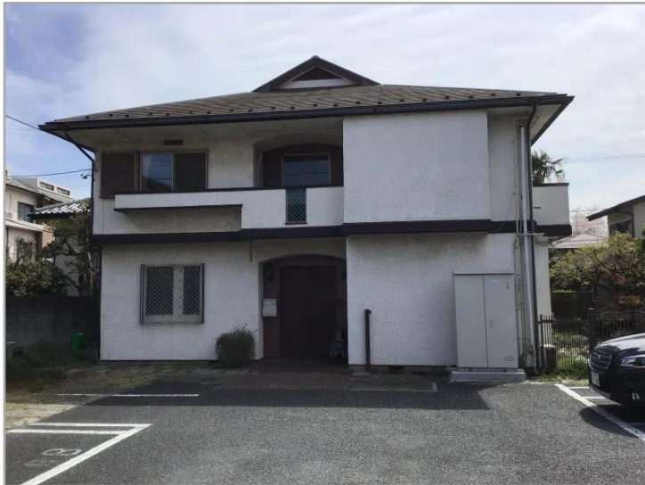
【やすらぎの里 松庵】施設外観 1
