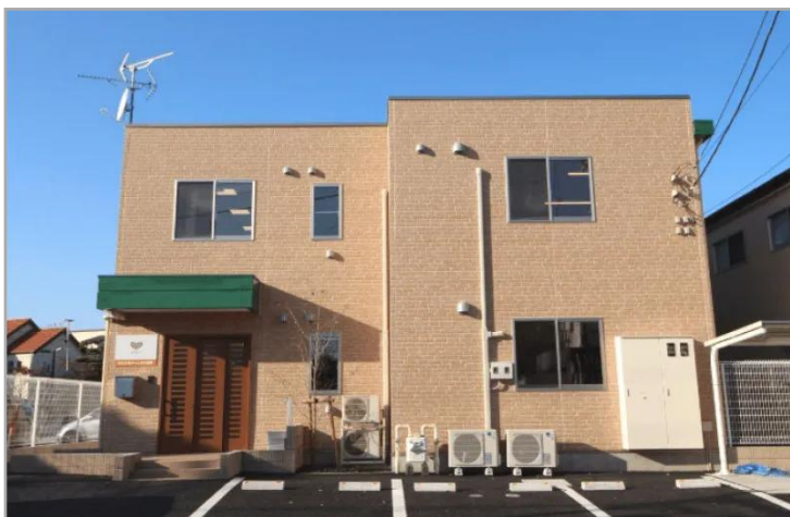
【はなまるホーム川口芝西の外観】
