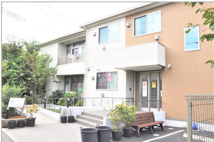
【愛・グループホーム瀬ヶ崎の外観】
