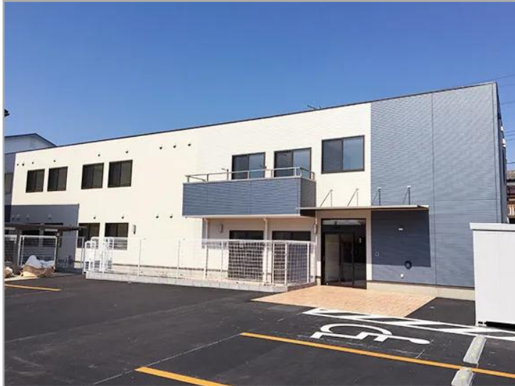
【愛の家グループホーム上尾本町の外観】
