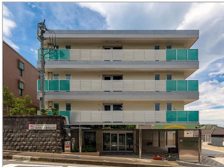
【エクセレント横濱北寺尾】外観
