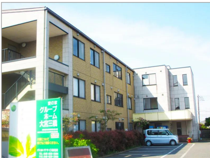
【愛の家グループホーム大宮三橋の外観】
