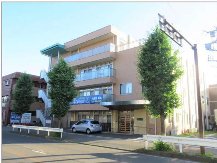
【スタイルケア緑の森小池ホームの外観】 幹線道路沿いで車でのアクセスも便利です。
