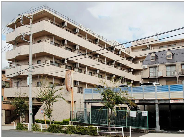
【ロマンヒルズ西台ハイライフ南】外観
