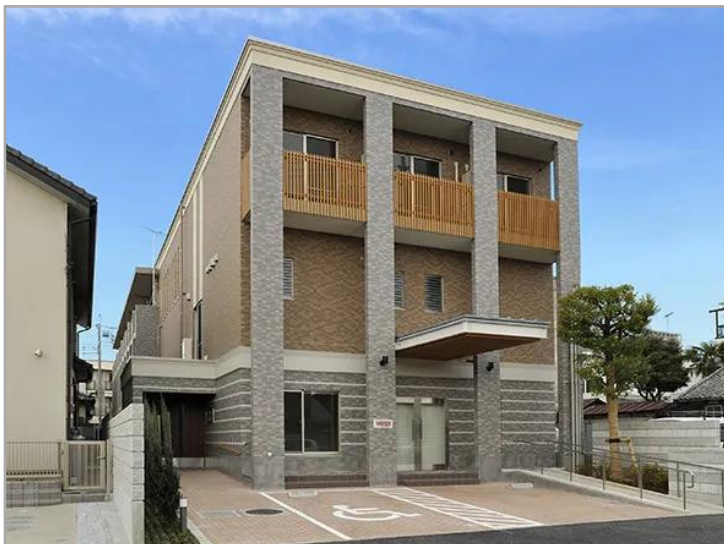
グループホームみんなの家・岩槻本町（外観） 3階建て（1,2階グループホーム）、18名定員。
