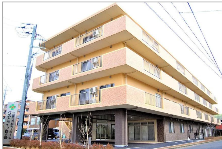
【ベストライフ鶴ヶ島の外観】
