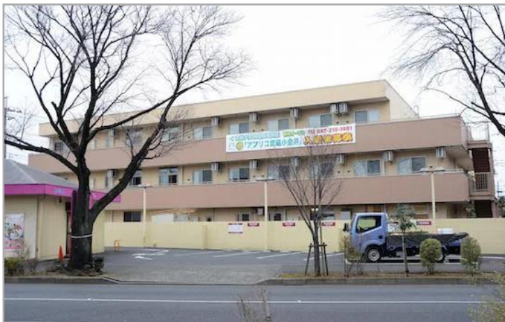
【アプリコ武蔵小金井】：外観
