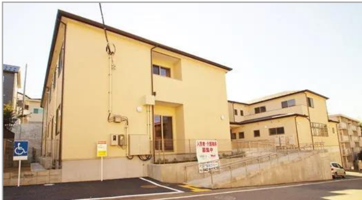
ムート座間くりはら 外観
