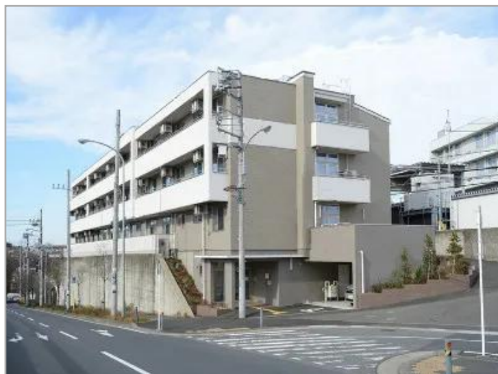
【プレザンメゾン横浜羽沢町】木造 地下1階地上3階建の清潔感のある建物です。
