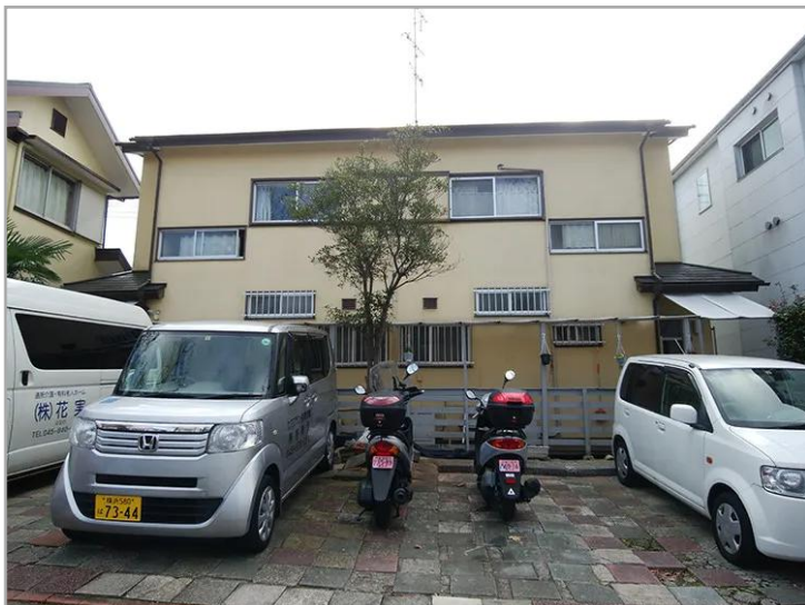
有料老人ホーム花実(港南台) 外観1
