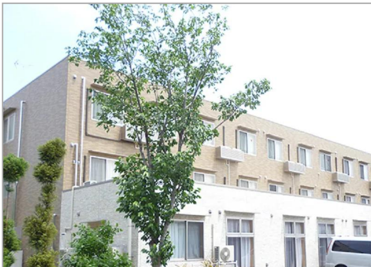
【トミオ桶川べにはなテラス・外観】
