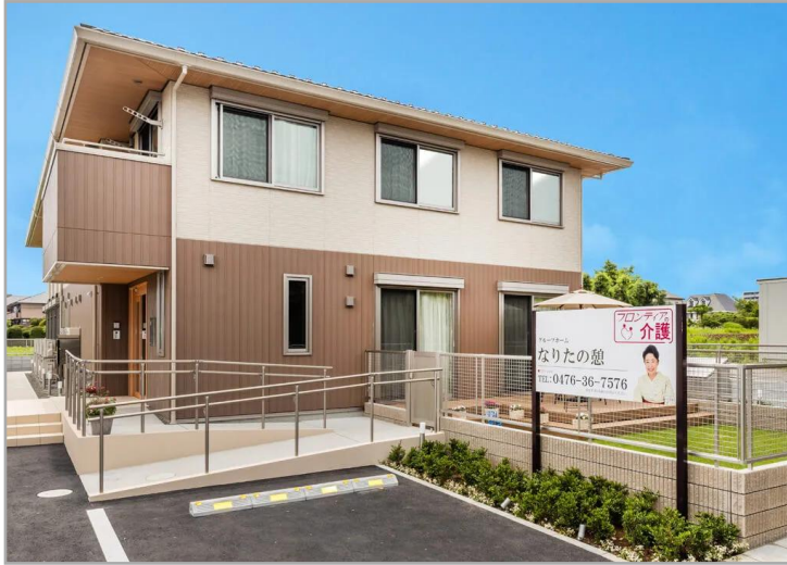
【グループホームなりたの憩の外観】
