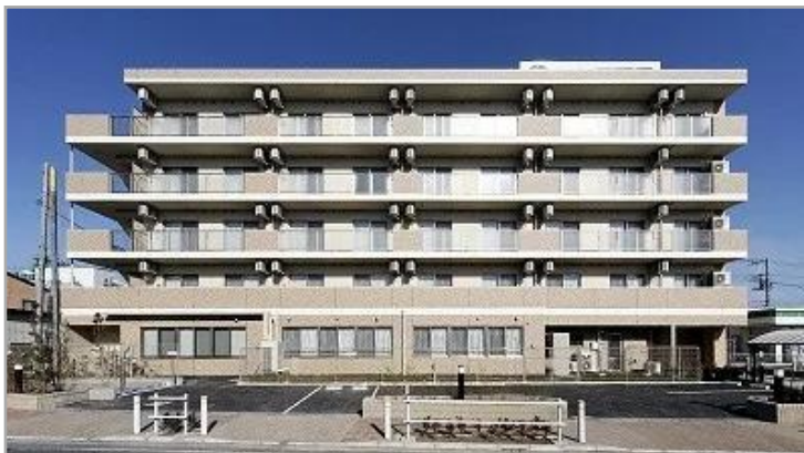
【そんぽの家板橋三園】外観
