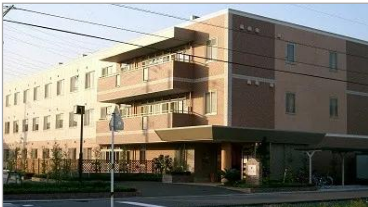
そんぽの家越谷 外観 閑静な住宅街に佇むホーム
